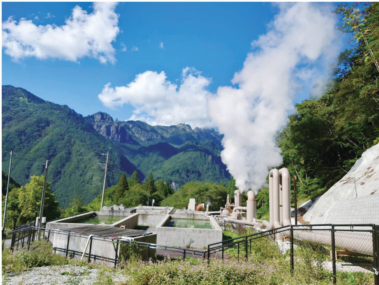
奥飛騨温泉郷 中尾地熱発電所 会員撮影
